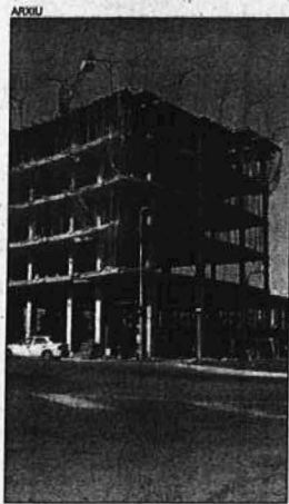
Un bloc de pisos en construcció
